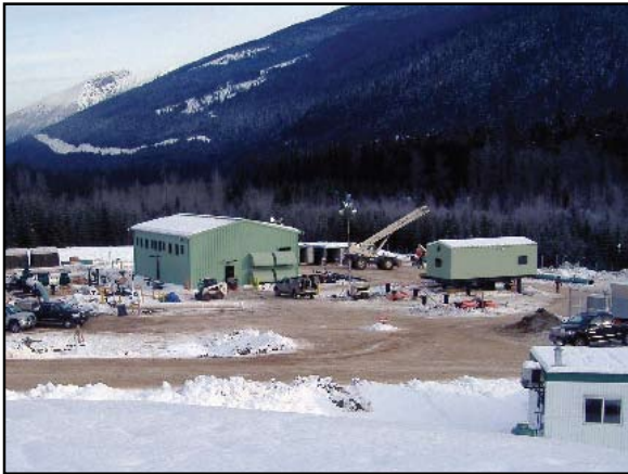
Poste de pompage Chappel (Colombie-Britannique)
