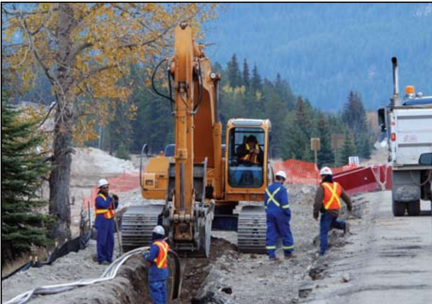
Creusement du fossé près du ruisseau Sucker (Alberta)
