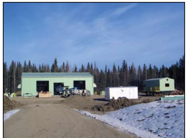
Poste de pompage Wolf (Alberta)
