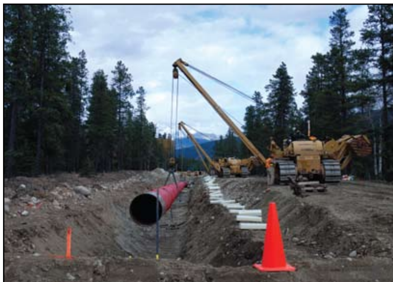
Pose d'un bout de canalisation à Jasper (Alberta)
