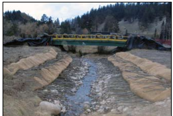
Remise en état préliminaire des berges du ruisseau Cottonwood (Alberta)
