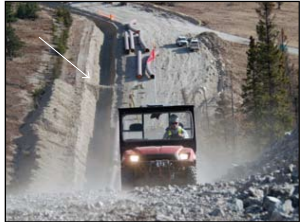
Exemple de remblai (Alberta)
